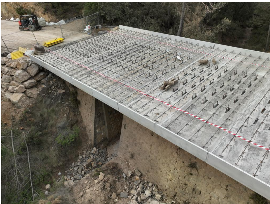
Figure 6: Losa parcialmente prefabricada en CV-10 La Yesa (Valencia).
