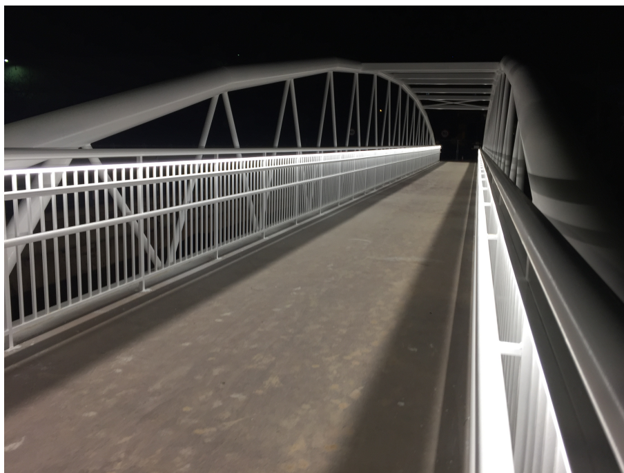
Figura 5: Pasarela ciclista en Vilamarxant (Valencia).
