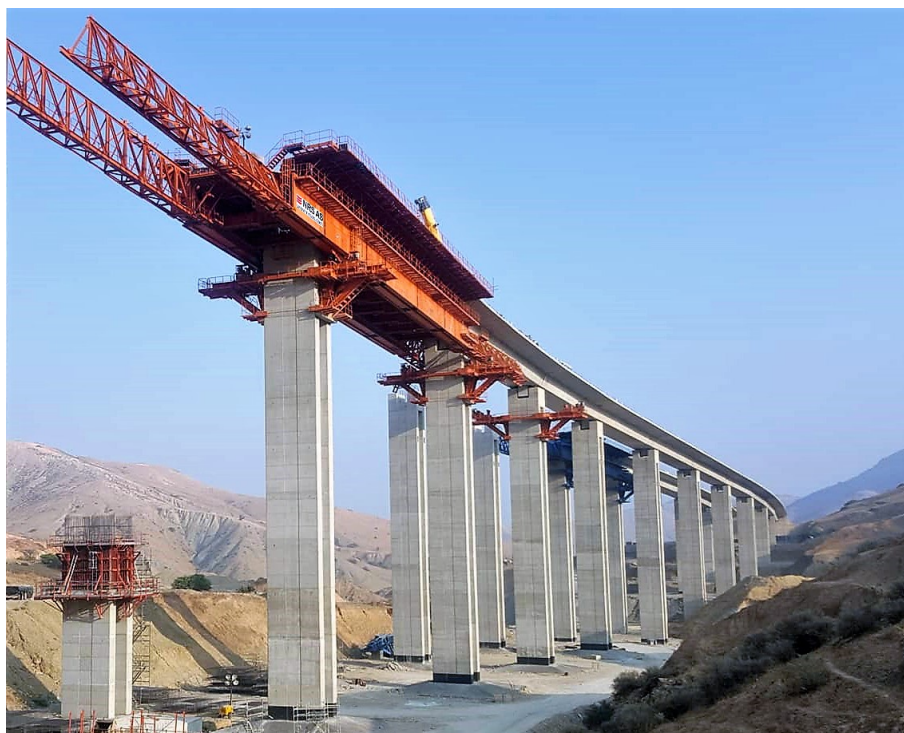
Figura 3: Viaducto 03B en construcción (Mascara, Argelia).
