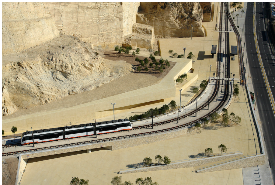
Figura 1: Paso elevado y muros de contención en parada Sangueta del tranvía de Alicante.
