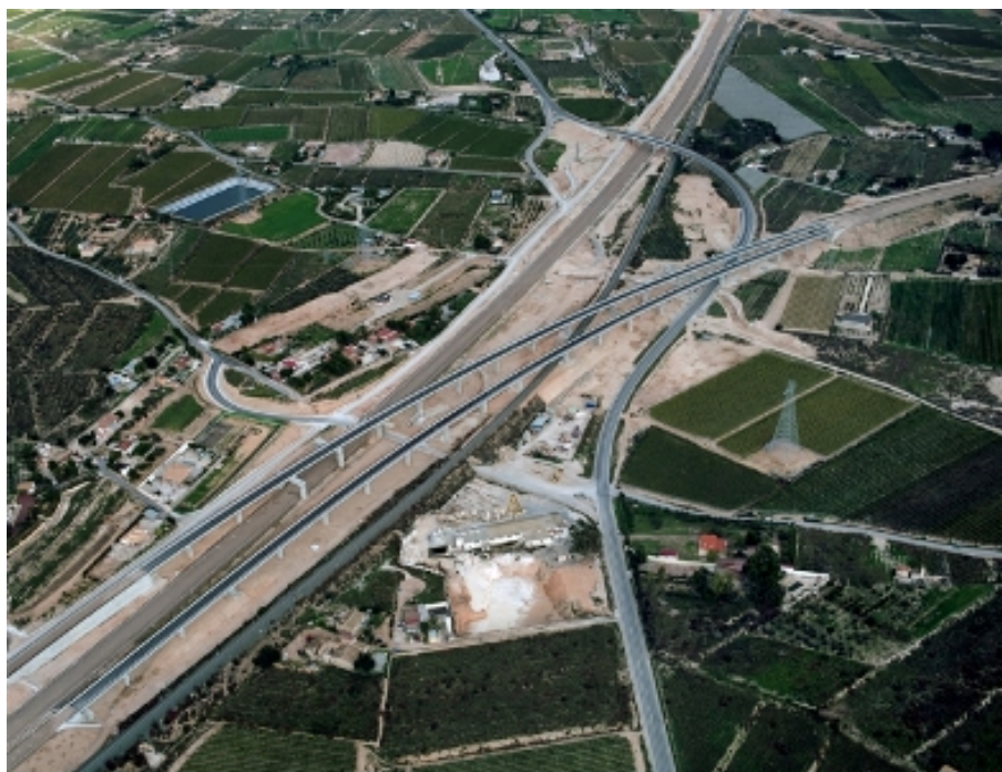
Figura 2: Viaductos AVE Madrid–Levante en Novelda.
