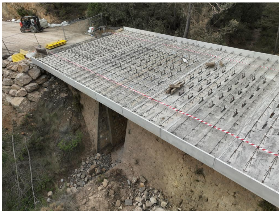
Figura 6: Losa parcialmente prefabricada en La Yesa (Valencia).
