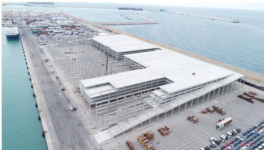
Figura 4: Silo de almacenamiento de vehículos en el puerto de Valencia.
