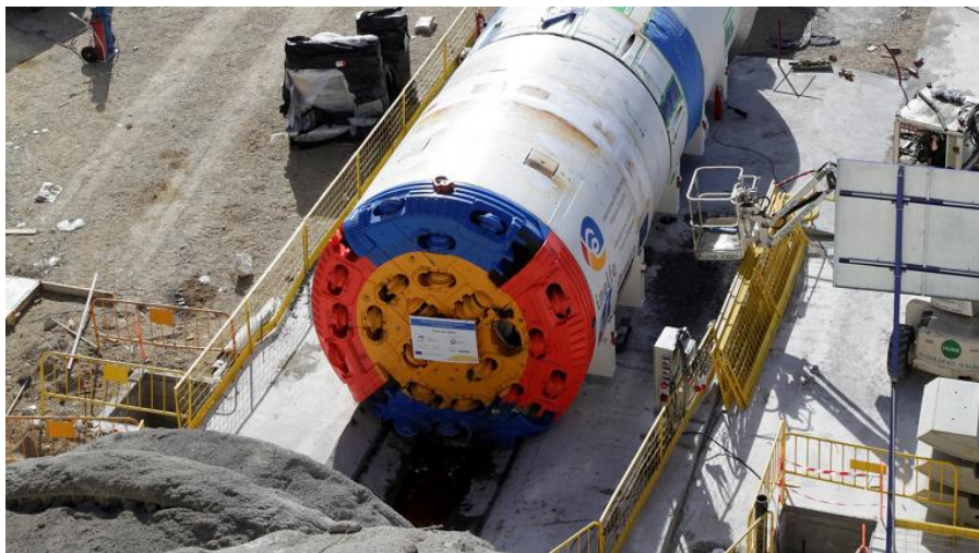
Figura 1: Tuneladora Alberes (Fuente: Red Eléctrica de España)
