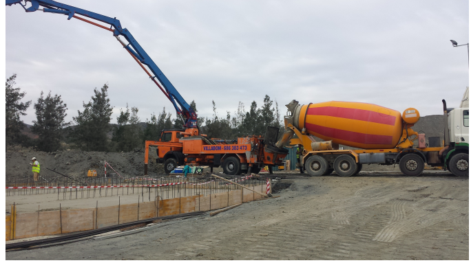
(b) Bomba de hormigón (Villabomb).
